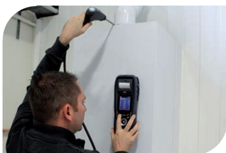
Contrôle de chaudières
