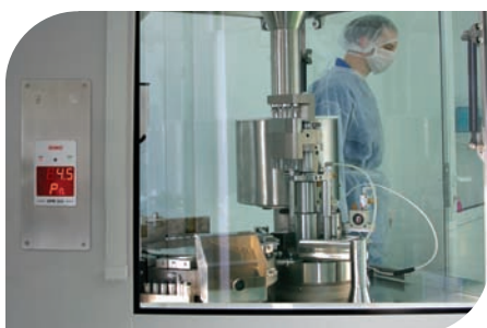
Surveillance de salles blanches
