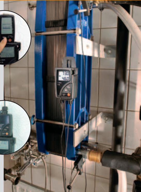
Contrôle d'installations techniques (contrôle du retour en temp.) dans les lieux de production
