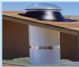
On utilise fréquemment les lucarnes tubulaires pour introduire la lumière du jour dans les vestibules et les cabinets. La lumière est, naturellement, entièrement normale et fournit autant de luminosité qu'une ampoule incandescente de 100 watts.
