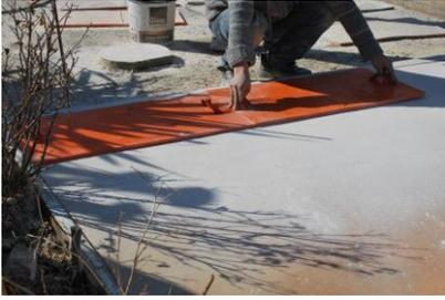
**Positionnez vos moules de marquage.** Le départ d'empreintes est très important. Un décalage de quelques centimètres au début entraîne un décalage de quelques dizaines de centimètres en bout d'ouvrage.
