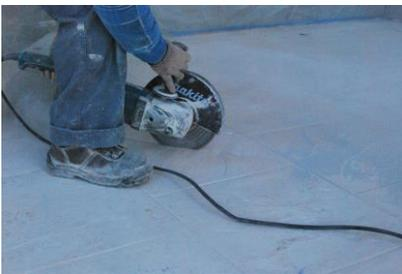
**Décoffrez, tracez et disquez** les joints de votre dalle béton tous les 5 mètres par la plus grande longueur et tous les angles saillants, le but étant de créer une faiblesse pouvant guider une potentielle fissuration.
