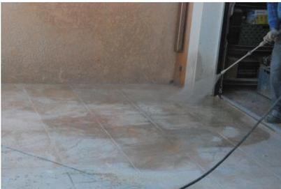
**Nettoyez votre dalle** à l'aide d'un jet d'eau ou d'un nettoyeur haute pression, faire un nettoyage doux en plusieurs passes si nécessaire. Pas de buse rotative qui pourrait agresser le béton encore frais.
