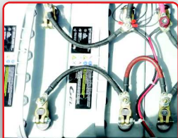
BATTERIES : Gel 4 x 12V/76A (C5) POIDS BATTERIES : 4 x 29 kg DIMENSIONS (mm) : L 323 x l 162 / h 235
