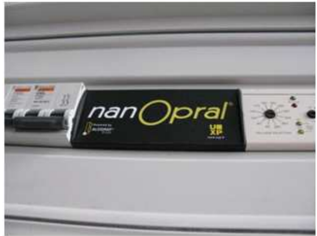
Exemple d'intégration dans un tableau électrique standard
