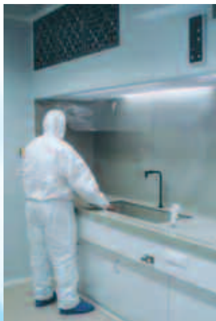
Plafond soufflant CLASSE ISO 4 sur poste de chimie en salle blanche
