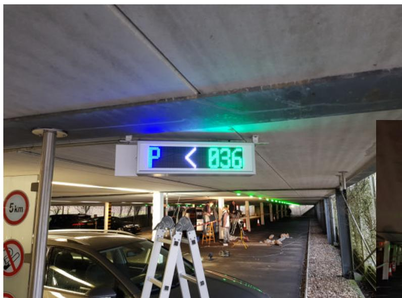
Ce système est composé est composé d'un ou plusieurs afficheurs 7 couleurs affichant la lettre **P** (Parking) en **bleu**, de chevrons dynamiques pour l'orientation des véhicules et de têtes de mesure et détection des véhicules sur leur place. Un bus de terrain RS485 permet le dialogue de tous les modules (afficheur et têtes de mesure) et également la configuration. Le nombre de place restante est affiché en vert. Dès que le parking est plein on affiche **FULL** ou **COMPLET** en **rouge**.
