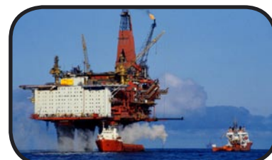
Inspection de plateforme
