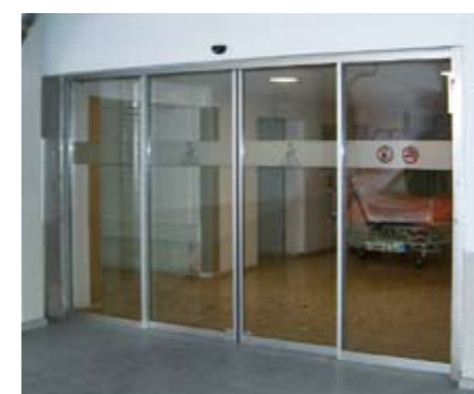
Les portes coupe-feu et pare-fumée coulissantes facilitent le passage mains-libres dans la vie quotidienne. En cas d'urgence, elles freinent la propagation de la fumée et du feu.
