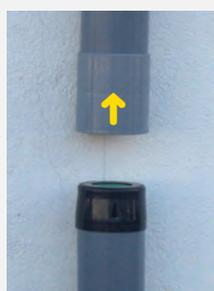
Poser le filtre anti-odeur sur la partie basse du tuyau de ventilation. Réaliser un joint de silicone sur la partie basse et sur le pourtour du filtre
