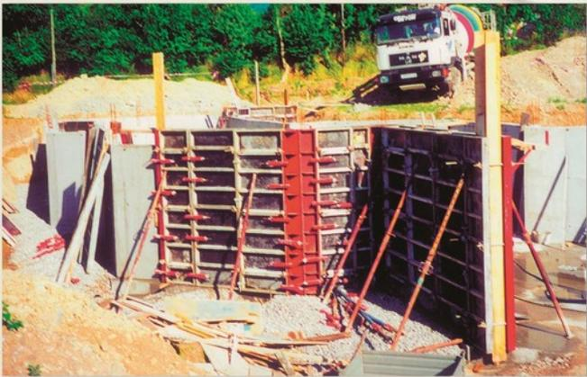
Mettre en place les crochets grue aux joints des panneaux
