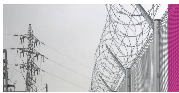
Bavolet Haro avant installation du réseau défensif
