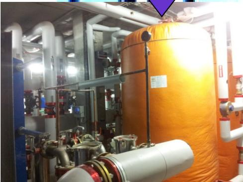
Traitement d'une boucle eau chaude sanitaire d'immeuble avec une chambre inductive inox 316L. Avant pose du calorifuge sur la bobine inductrice.
