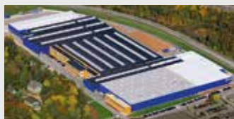
Hörmann KG Eckelhausen, Allemagne
