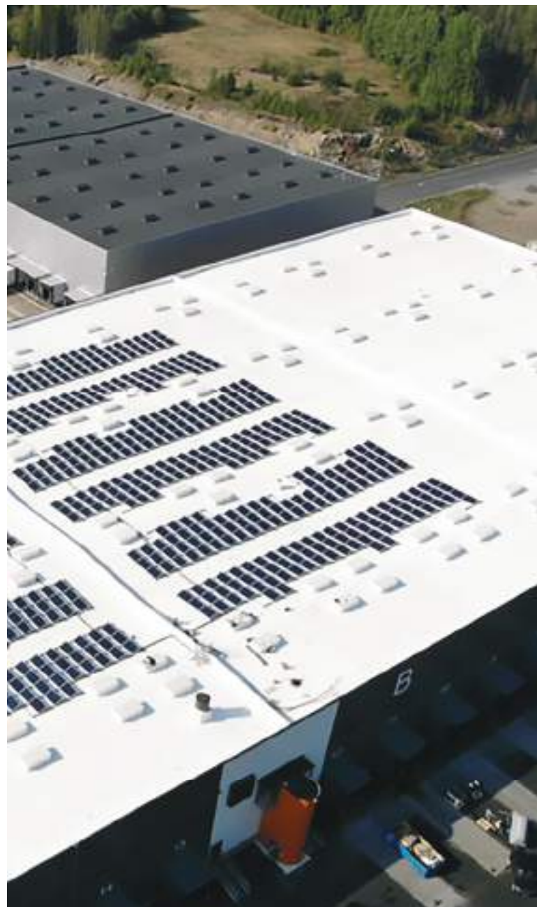
Bâtiment industrielle - Finlande 11 000 m 2 RENOLIT ALKORPLAN F + profilés RENOLIT ALKORPLAN Solar
