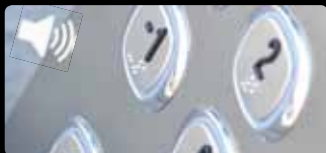
Synthétiseur vocal pour signaler l'arrêt à l'étage
