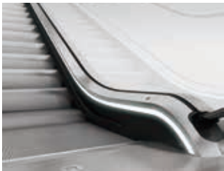
Éclairage de plinthe, bandes
