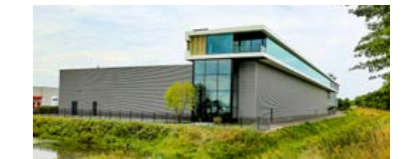
Une nouvelle usine de production de chargeurs compacts Pitbull et de Biga Topliner est mise en service sur le Patagonweg à Etten-leur
