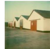
La construction de la nouvelle usine à Achtmaal
