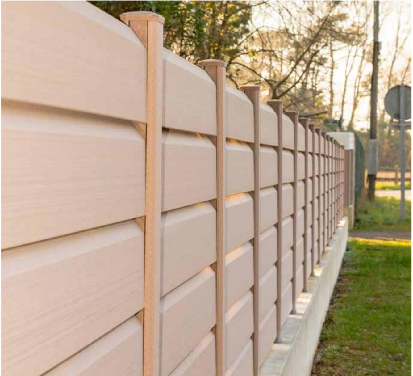
Chantier SISTÄ - Pose sur muret avec platine - Poteaux et remplissage 100% Loryza
