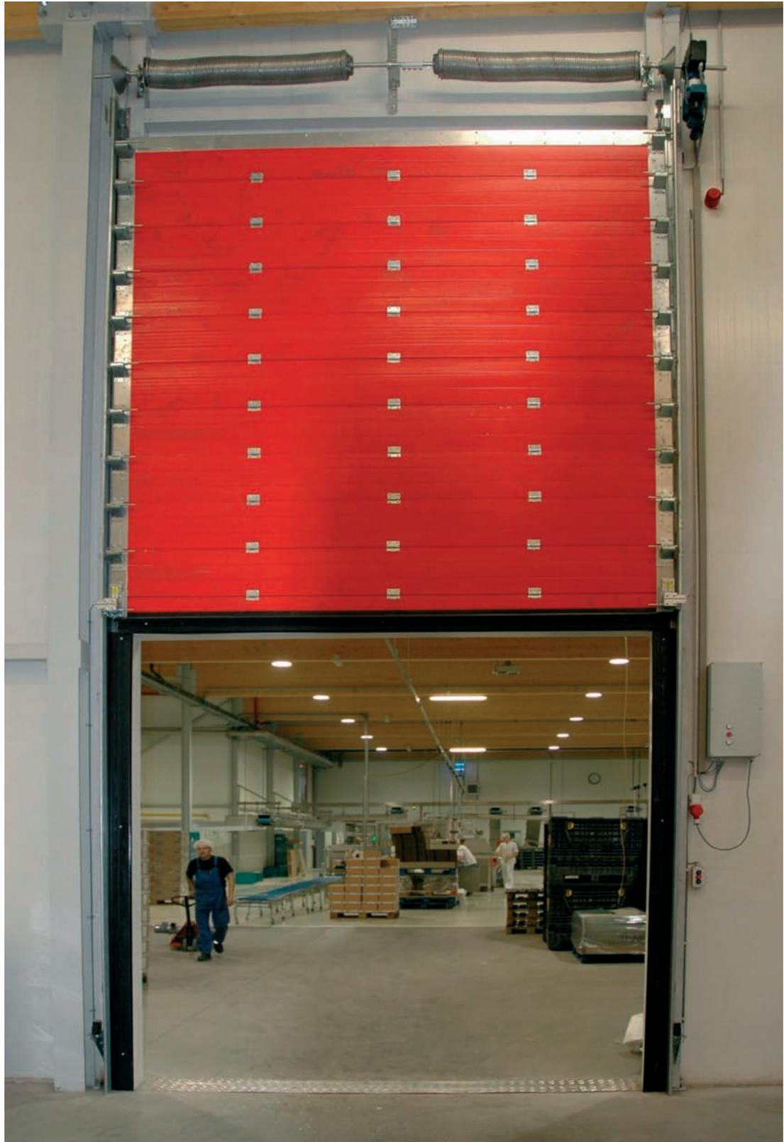
Le tablier de la porte sectionnelle est constitué de panneaux en matière synthétique RF60
