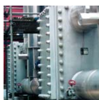
Compabloc vertical pour la récupération de chaleur liquide/liquide
