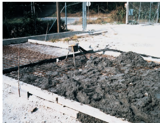
Elle transporte sans problème même du béton d'une granulométrie max. de 20 mm sur une grande distance.
