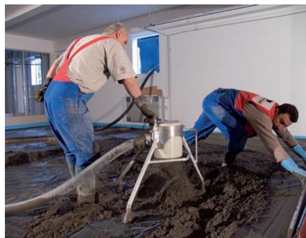
Le Mixokret transporte les matériaux les plus divers. Chapes et sable jusqu'à une granulométrie de 8 mm...
