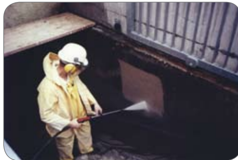
Nettoyage béton
