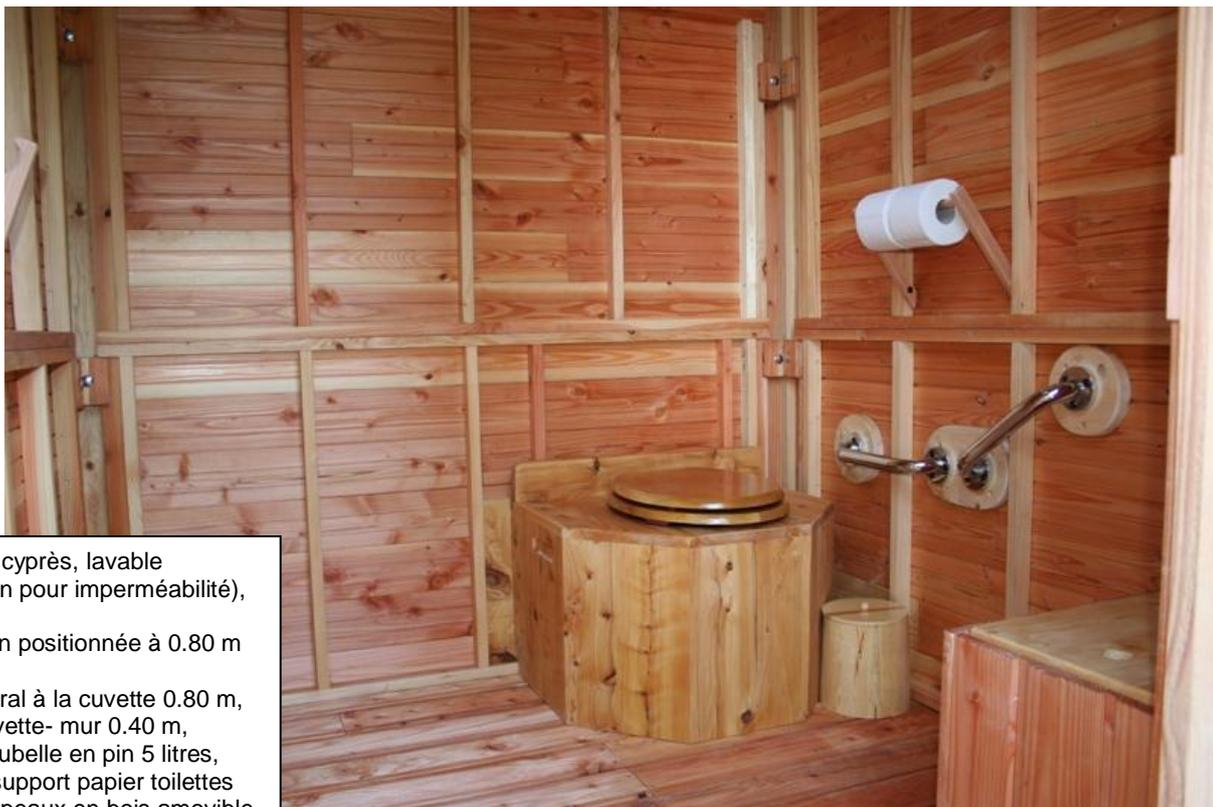
Coffre assise en cyprès, lavable (huilé à saturation pour imperméabilité), hauteur 0.46 m, Barre de maintien positionnée à 0.80 m du sol, Espace libre latéral à la cuvette 0.80 m, Distance axe cuvette- mur 0.40 m, Accessoires : poubelle en pin 5 litres, porte manteau, support papier toilettes et réservoir à copeaux en bois amovible, support gel hydro alcoolique.
