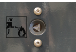
Déverrouillage pompier avec serrure Triangle 11mm
