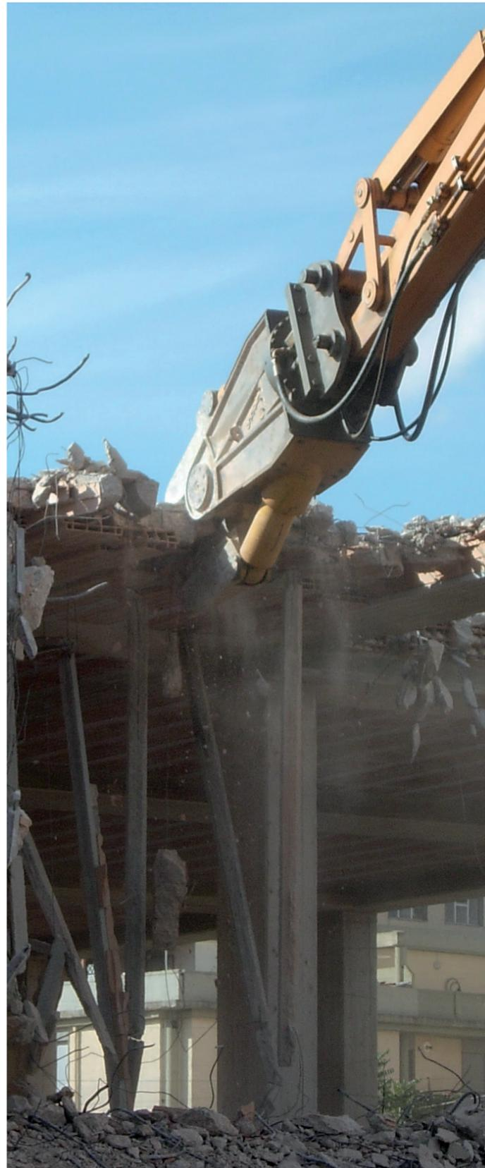
Rotation hydraulique continue à 360°, avec soupape de protection, qui permet une démolition efficace dans la plupart des conditions logistiques et une prise toujours optimale du matériau à démolir
