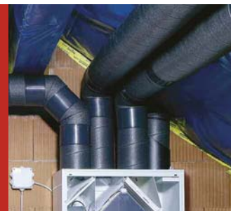
Réduction du temps de montage: conduits isolés IsoPipe pour réseaux d'air extérieur et rejeté.
