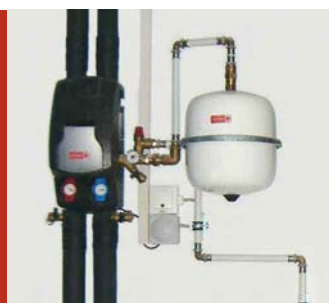
Montage du module hydraulique pour le raccordement du puits canadien à eau glycolée SEWT.
