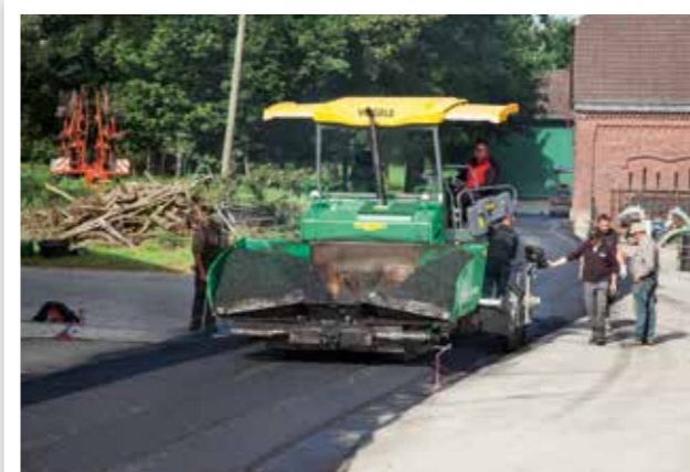
POSE D'ENROBÉ EN ZONES INDUSTRIELLES ET COMMERCIALES
