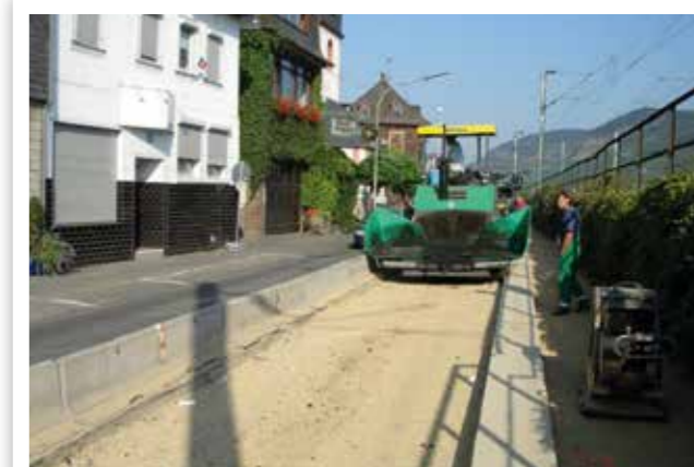
RÉFECTION DE VOIES URBAINES
