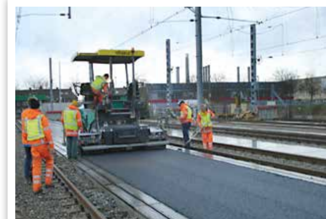
POSE D'ENROBÉ SUR LES QUAIS DE GARE
