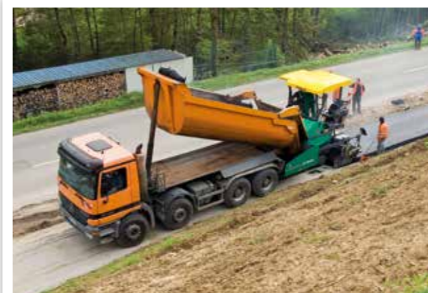
POSE D'ENROBÉ SUR TROTTOIRS/PISTES CYCLABLES COMBINÉS
