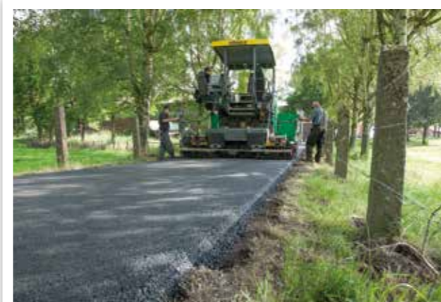
RÉFECTION DE VOIES D'ACCÈS
