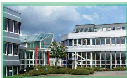
Fabrication en Allemagne
