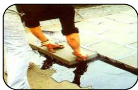
Collage d'isolant
