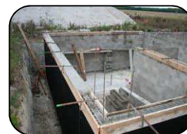
Imperméabilisation fondations
