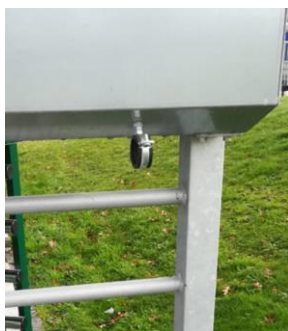
Guide pour passage de fourreaux en hauteur
