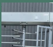
Mécanisme accessible par caisson avec serrure
