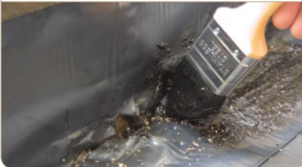
Le Répar'toit® Express s'applique facilement à l'aide d'un pinceau, d'une truelle ou d'une brosse sur les trous, jointures, sur les tuyaux etc. Il permet de réparer immédiatement les toitures qui fuient. Son petit conditionnement permet un stockage facile dans un bureau ou dans un véhicule. Il est légèrement plus épais que le Répar'toit® original.
