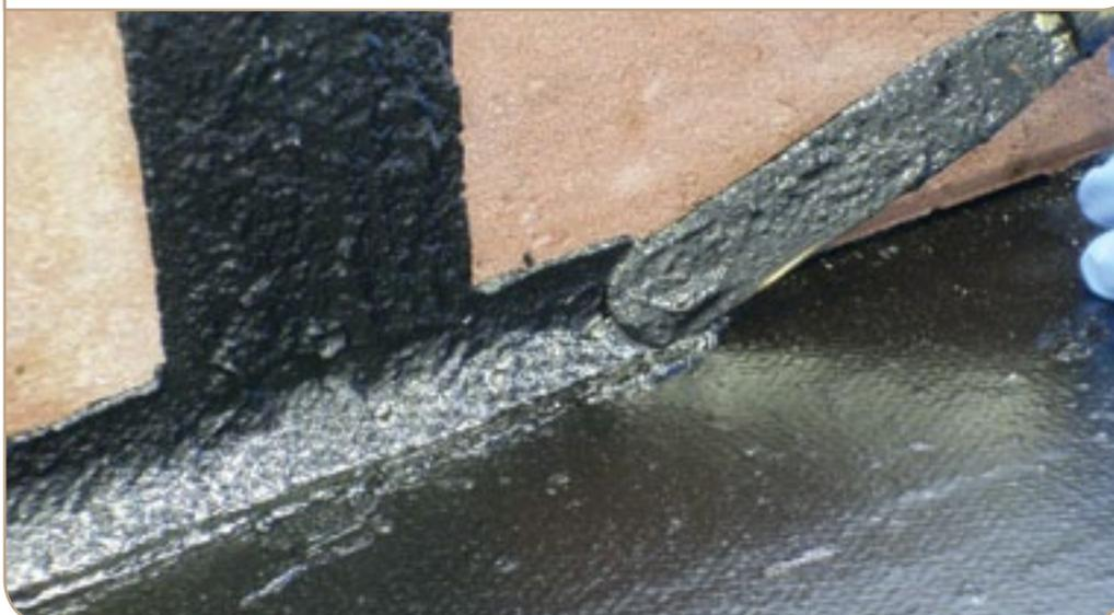
Le Répar'toit® Mastic peut-être appliqué verticalement ou horizontalement. Il permet ainsi de boucher les trous pour éviter que l'eau ne stagne et ne dégrade prématurément votre toiture.
