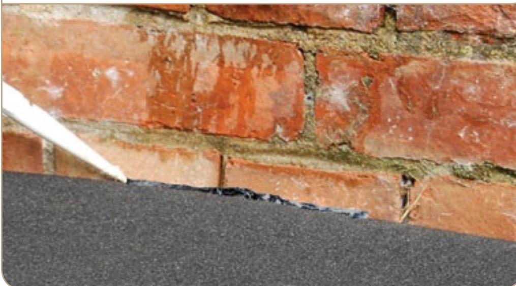
Mastic à base de bitume idéal pour réparer et prévenir les fuites provenant des toits, des gouttières et des tuyaux. Il peut être appliqué sur les feutres bitumés, le métal, la peinture, la pierre, la brique et les matériaux de construction en plastique.
