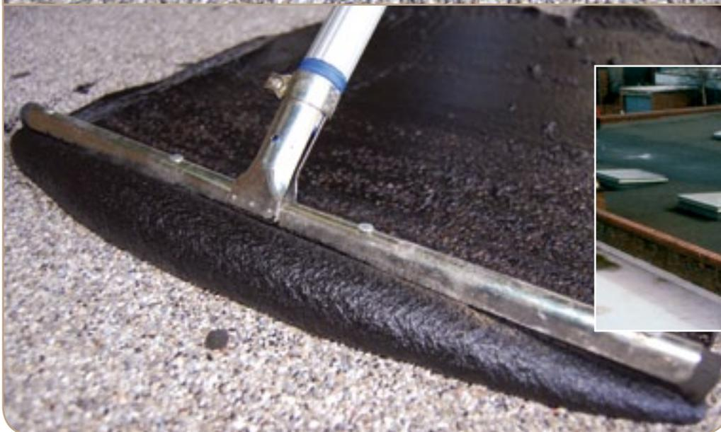
Versez directement le Répar'toit® Coulable en petite quantité sur votre toiture. Utilisez une raclette ou un platoir pour appliquer et lisser sur l'épaisseur et la surface voulu. Pour l'application d'une couche supérieure à 3 mm d'épaisseur, il impératif de laisser sécher 24 heures avant d'appliquer une autre couche.
