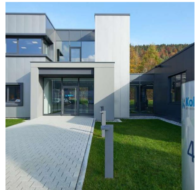
Kohler Betriebseinrichtungen DE - Immendingen
