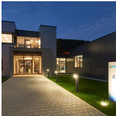
Kohler Betriebseinrichtungen DE - Immendingen
