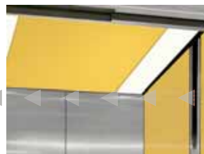
Techo en chapa de acero con fluorescentes.
