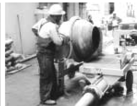
Les dimensions limitées facilitent la mise en place sous les toupies, bétonnières, etc.
