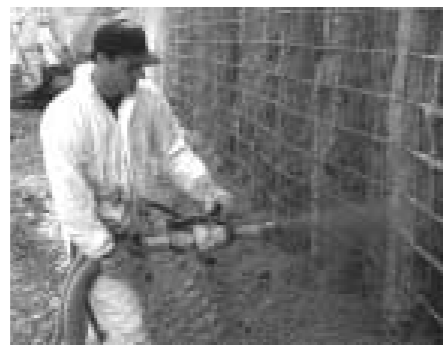
Béton projeté (spritz-beton)
