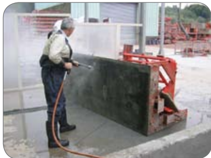
Décapage de banches métalliques
