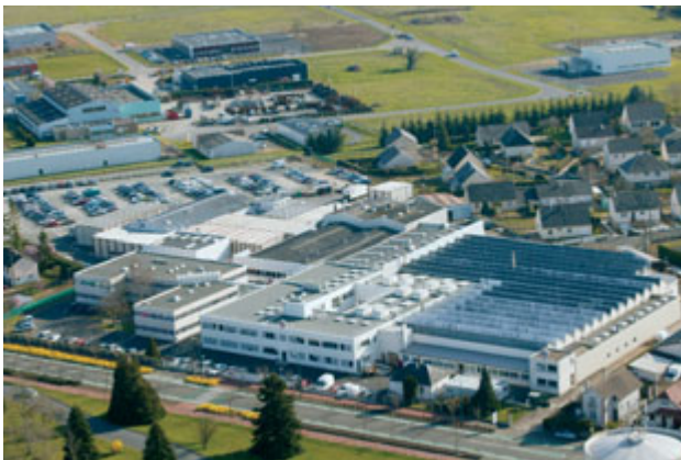
Siège social ARO, Château du Loir, France
