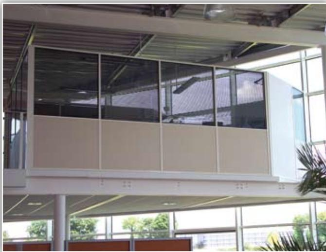
Clipsoplaque+ répond favorablement à la norme garde-corps sous couvert d'un montage spécifique. En effet, elle résiste au choc mou à 900 joules avec des couvre-joints (Réf.1031) vissés et le positionnement de traverses internes.
