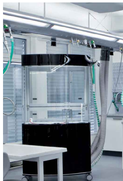
2 Système de ventilation: Connection aile d'énergie
