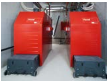
Chaufferie aménagée avec une cascade de 2 chaudières à granulés BioLyt.
