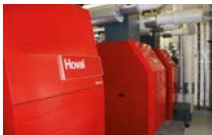
Centrale de chauffe avec cascade de 3 chaudières composées de 2 chaudières à granulés BioLyt et d'1 chaudière gaz à condensation UltraGas.
