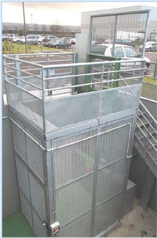
Gaine de l'élévateur réalisée suivant l'existant
