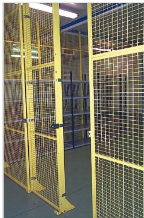
Zone sensible grillagée avec panneaux standard
