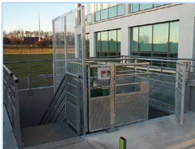
Porte et portillon avec serrures électriques
