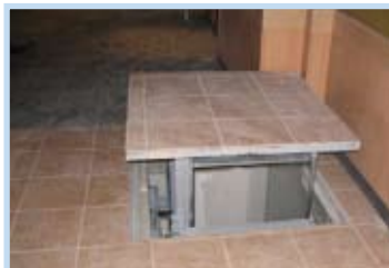
Trappe embarquée sur le point haut de la cage de l'élévateur
