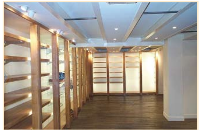
Structure aménageable (éclairage, supports produits, etc ...)
