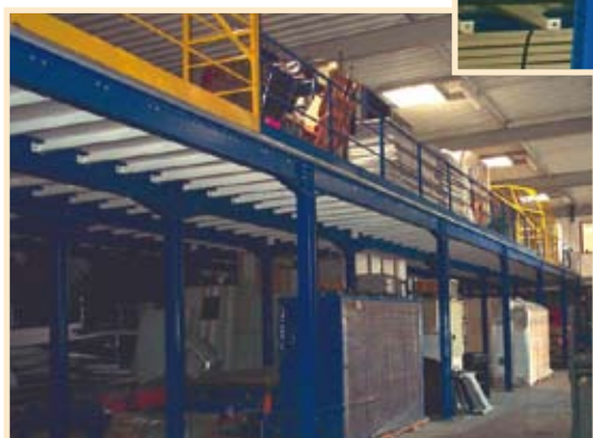
Structure sur poteaux avec renforts de stabilisation
