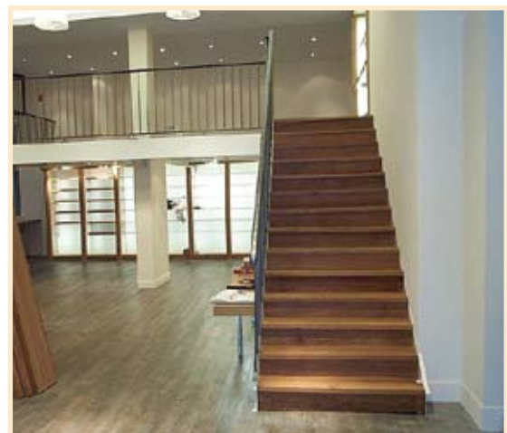
Escalier avec structure métallique et marches en bois
