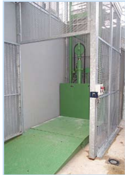
Elévateur charge 2500 kg, plateau 1500 x 1500 mm, course 3200 mm
