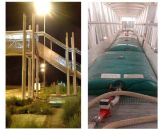
Passerelle de péage
