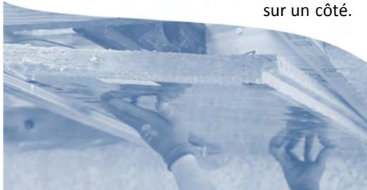
**2ème étape:** Laissez reposer à plat le panneau chauffant sur les 2 fourrures. Serrez-le contre les autres panneaux chauffants ou non chauffants.
