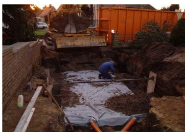
7. Recouvrement du réservoir GEOdek finie
