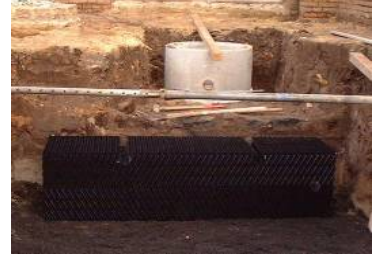
2. Mise en place de GEOdek
