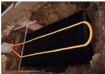
5. Mise en place du système de diffusion finie
