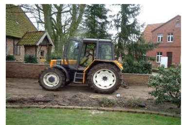
8. Fin du chantier
