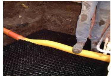
4. Mise en place du système de diffusion
