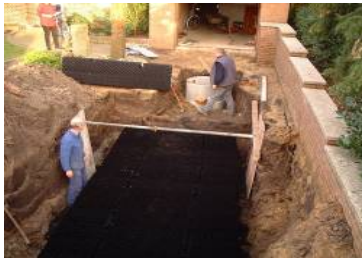
3. Mise en place du GEOdek finie
