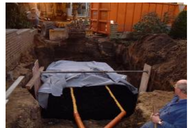
6. Recouvrement du réservoir GEOdek
