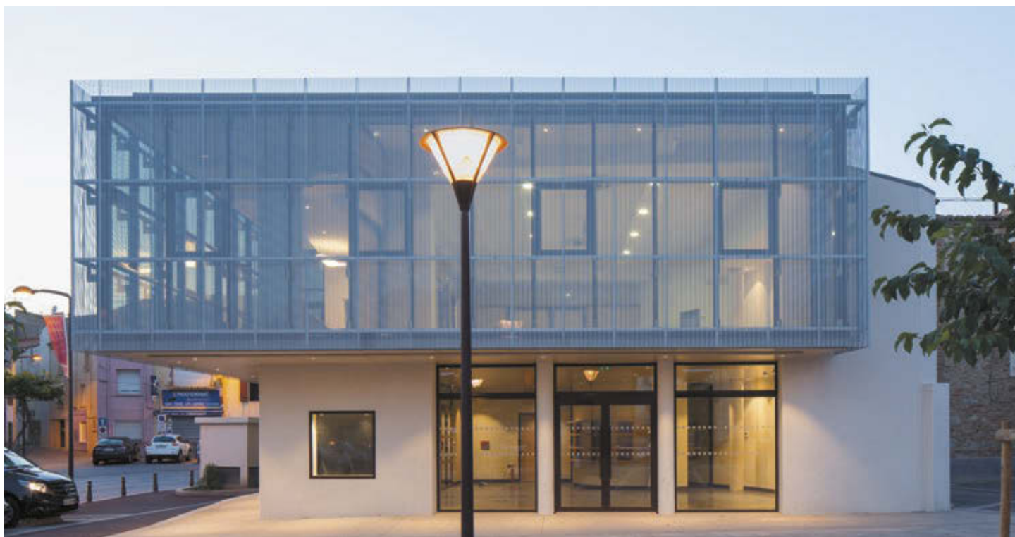
Office de Tourisme, Mas Capellans, Torrelles (France) - Architecte : Bernard Cabanne / Michel Génis - Entreprise : Sopribat
