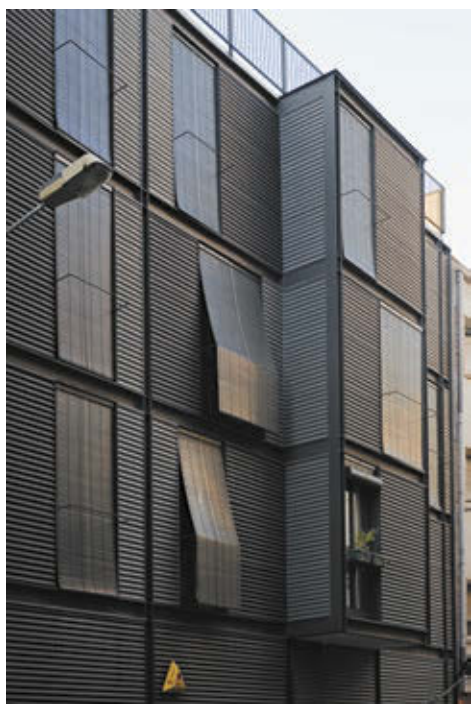
Immeuble d'habitation, Vilafranca del Penedès (Espagne) Architecte : STEM Arquitectes - Entreprise : Tot Cobre i zinc
