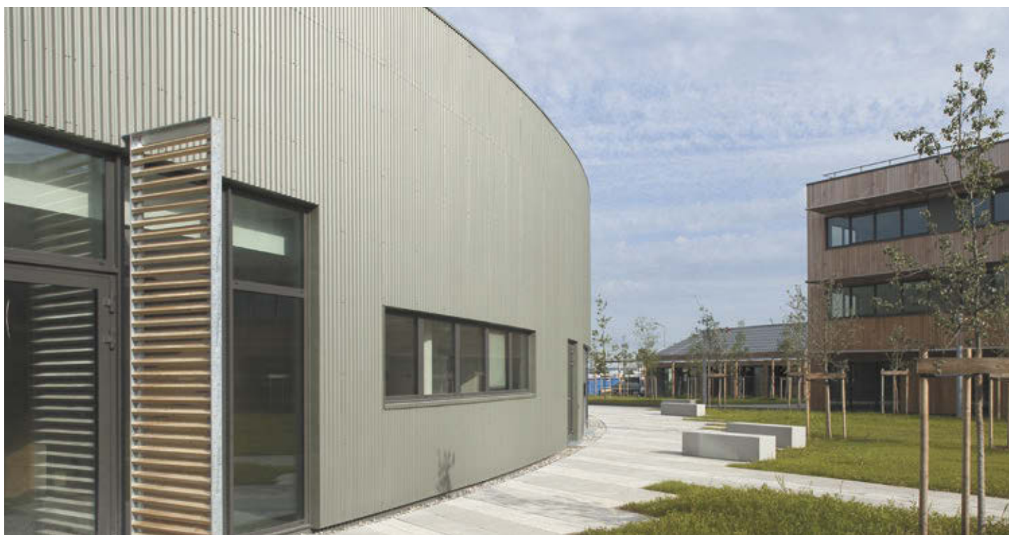
Bureaux Campus Veolia, Meyzieu (France) - Architecte : ARTE CHARPENTIER - Entreprise : VAGANAY
