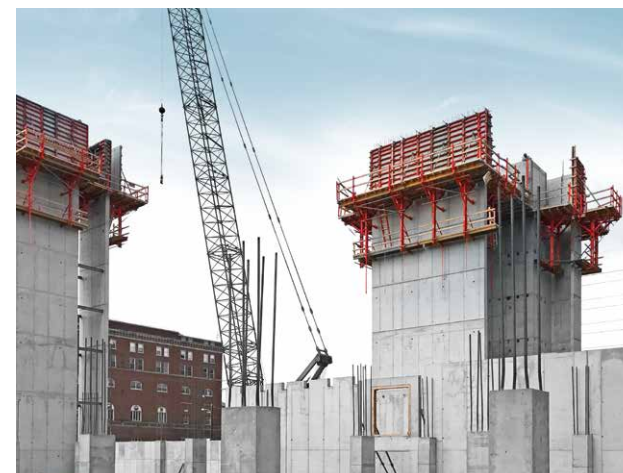
L'échafaudage grim pant KLK 230 est composé de consoles grim pantes, d'étais muraux, d'un platelage et de garde-corps.
