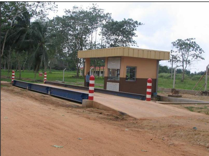
*Pont- Bascule tablier béton sur charpente métallique*
