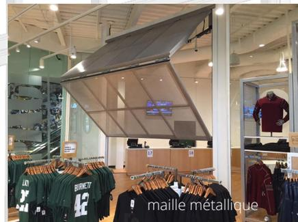
La porte-relevante se positionne sur une façade intérieure ou extérieure. Elle s'intercale entre une vêtture extérieure et un châssis (plein ou vitré) formant l'enveloppe isolante du bâtiment.
