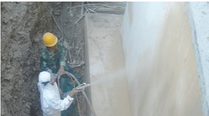
Revêtement de fondements en béton
