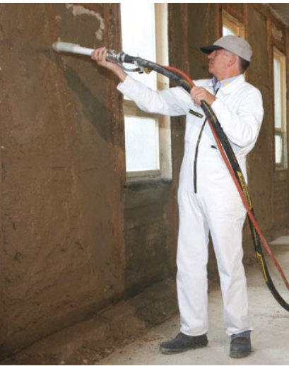
Projection d'enduit d'argile à l'intérieur
